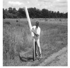
STEP 2 SLIDE VERTICAL SLEEVE Slide vertical en manga
